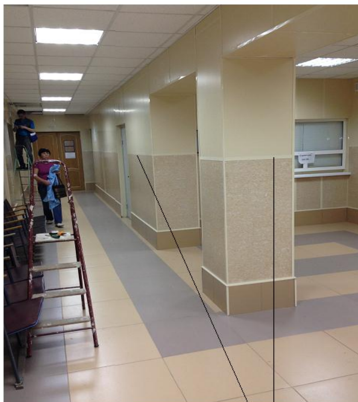
соединение Омега-профилем панелей разных декоров
