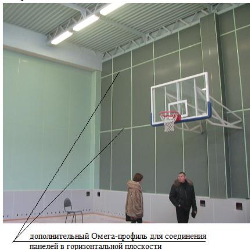
Рис. 11. Пример соединения панелей в горизонтальной плоскости с помощью Омега-профиля
